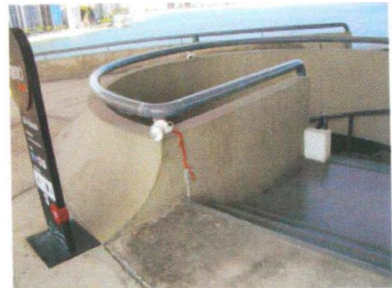
Imagem do local onde ficará a parada superior da plataforma.
