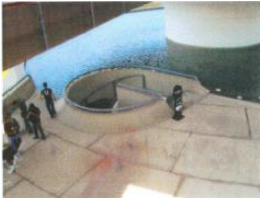
FOTO 1 – ACESSO AO SUBSOLO
